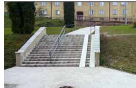
Opravené schodiště v Horním Oloví.
