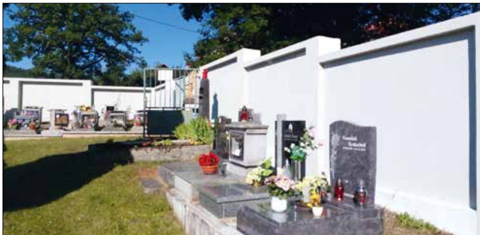
Proběhla i druhá fáze oprav hřbitovní zdi.
